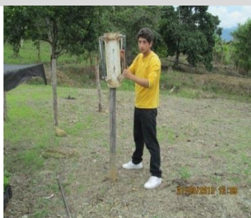
Figura 7. Colocación de postes de madera.
