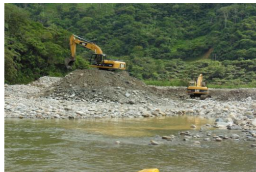
Proceso de extracción de grava aurífera con excavadoras de brazo largo.
