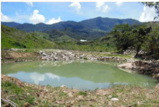
Piscina de sedimentación abandonada.
