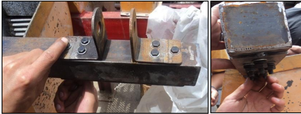
Fig. 15. Colocación de la base para los ejes de articulación (azimut).
