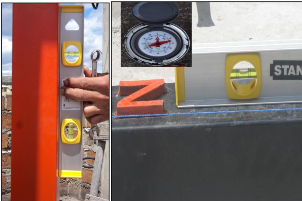
Fig. 14. Nivelación y alineación de la base y columna.
