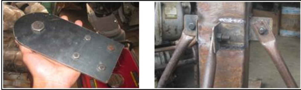
Fig. 4. Placas de acero y bases de los soportes de la columna.
