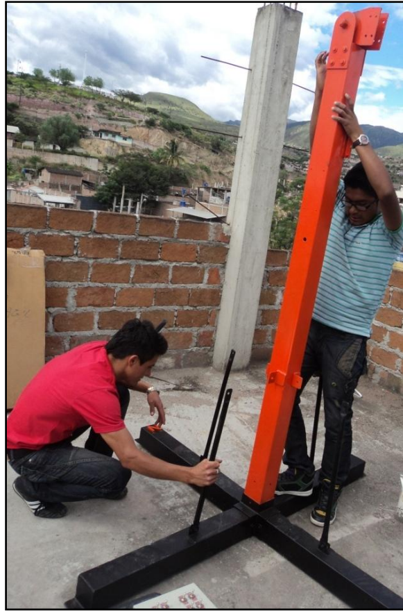
Fig. 13. Instalación de la estructura del colector.
