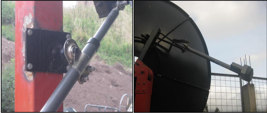
Fig. 18. Colocación de los actuadores lineales electromecánicos.
