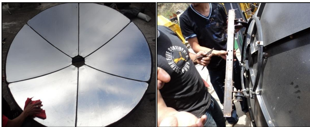
Fig. 16. Limpieza del reflector y posterior colocación del concentrador a la viga.
