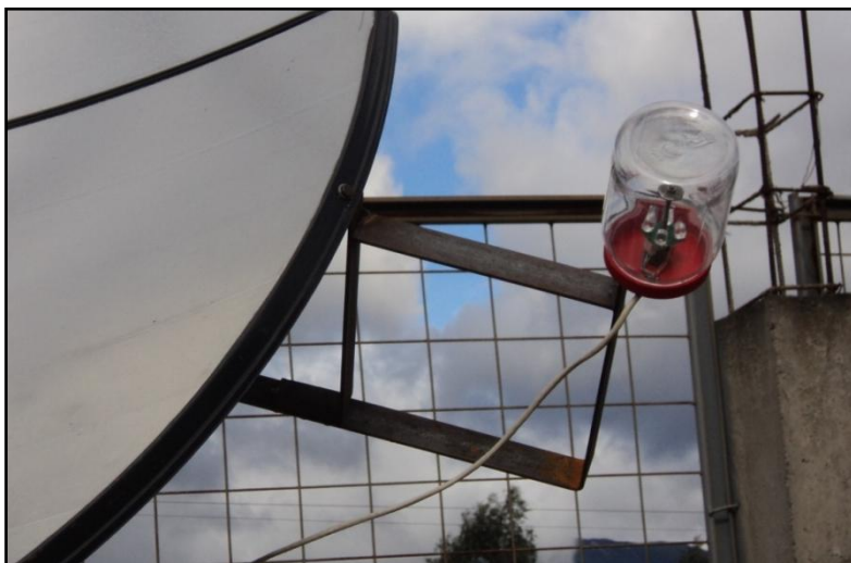
Fig. 20. Colocación de los sensores remotos.
