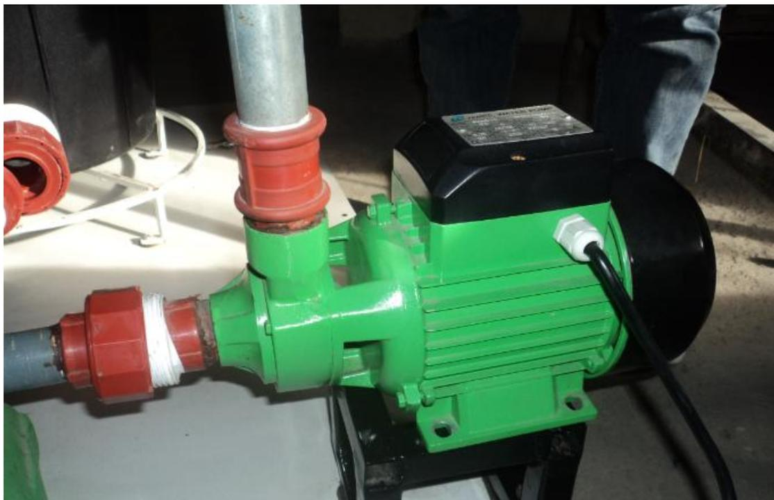
Fig.3.3. Bomba centrífuga JSW/10H alimentada por un motor monofásico de 1hp y velocidad nominal de 3450 rpm.
