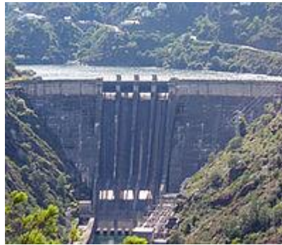
Fig. 10. Presa hidroeléctrica, Proyecto Hidroeléctrica Palomino.
