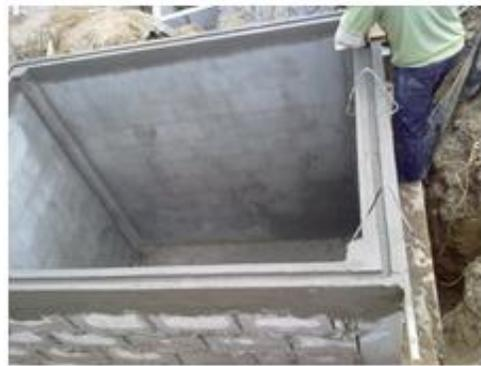
Después de construidos los tanques correspondientes, procedemos a realizar la excavación de las zanjas las cuales servirán para colocar la tubería y electroválvulas que comunicaran los tanques entre sí.
