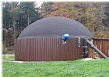
*Fig. 9 Digester con tanque de almacenamiento tradicional y cúpula de polietileno.*
