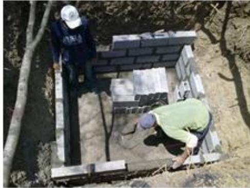
Ya levantadas las paredes de los tanques correspondientes, procedemos a enlucir las paredes de los tanques.
