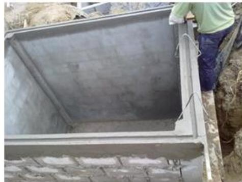
Después de contruidos los tanques correspondientes, procedemos a realizar la excavación de las zanjas las cuales servirán para colocar la tubería y electroválvulas que comunicaran los tanques entre sí.
