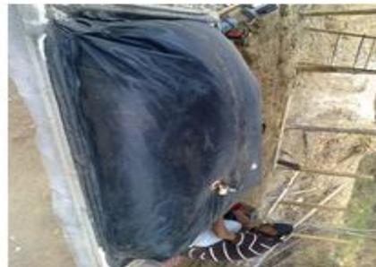
Una vez realizadas las pruebas de hermeticidad, y controladas las mismas, procedemos a preparar la mezcla de estiércol con agua para llenar el biodigestor.
