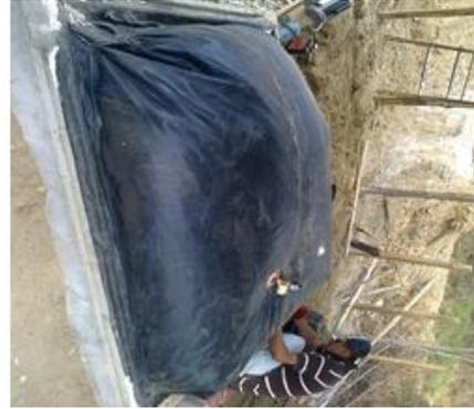
Una vez realizadas las pruebas de hermeticidad, procedemos a preparar la mezcla de estiércol con agua para llenar el biodigestor.
