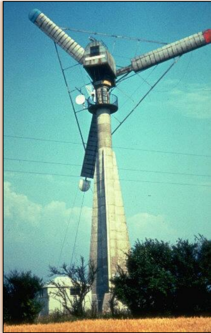
Figura 1.3: El primer aerogenerador de corriente alterna.
