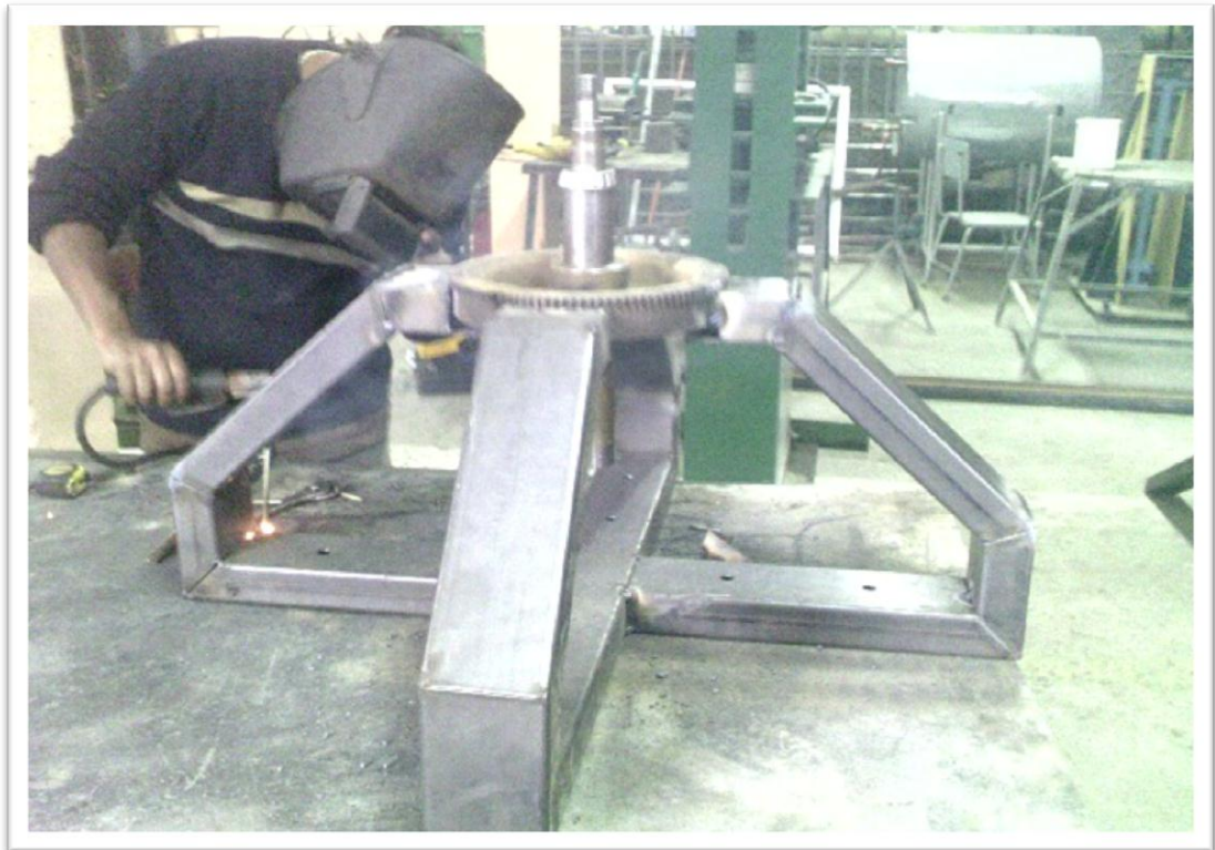
Figura 3.20: Proceso de construcción de la Base de Generador.
