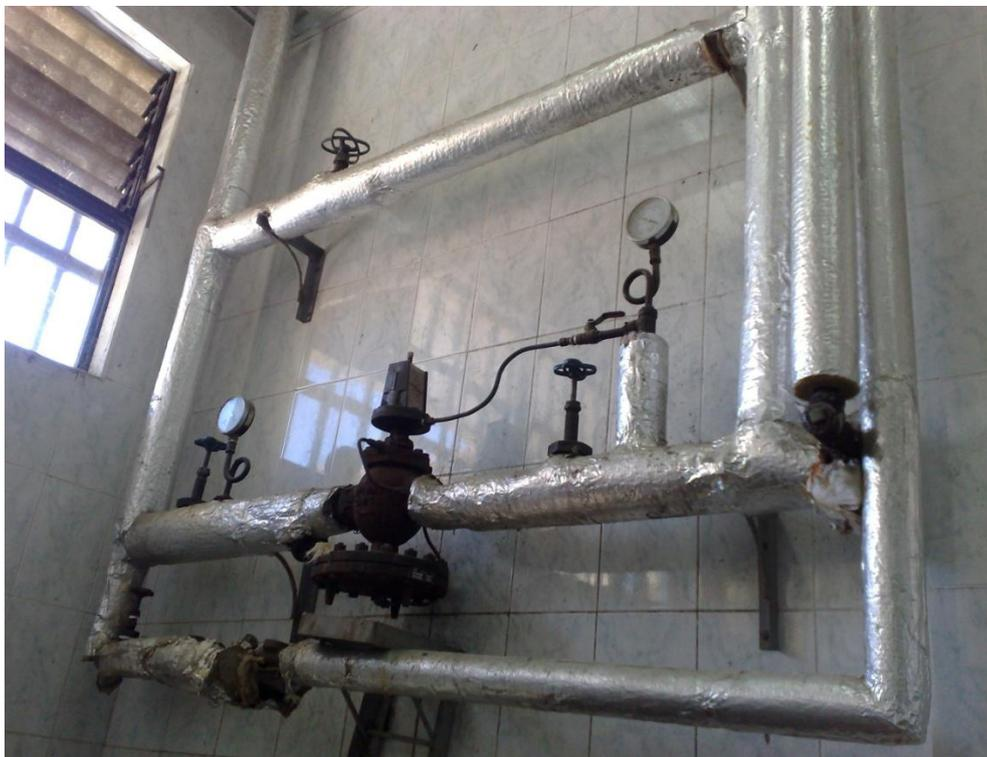
Figura 59: Válvula reguladora de presión en el área de lavandería.
