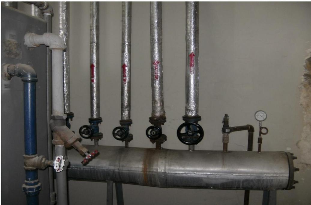
Figura 53: Colector de vapor.
