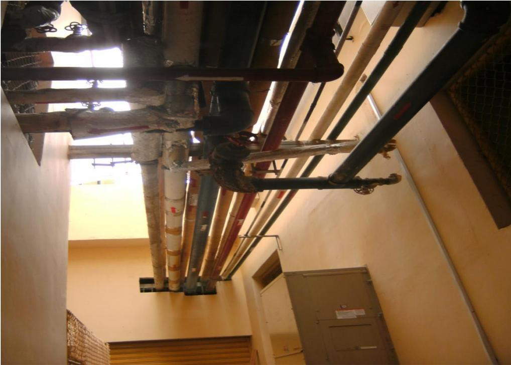
Figura 54: Tuberías de vapor que van a los diferentes puntos de consumo.
