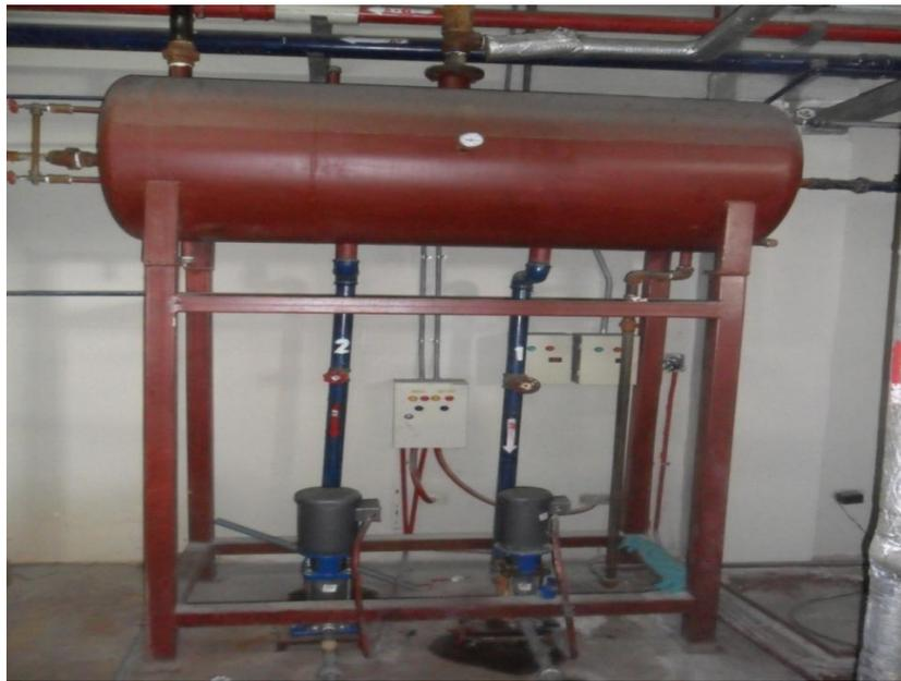
Figura 30: Tanque existente para el agua de alimentacion.
