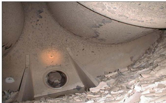
Figura 18: Acumulación de incrustaciones en el fondo del cuerpo de presión de la caldera.
