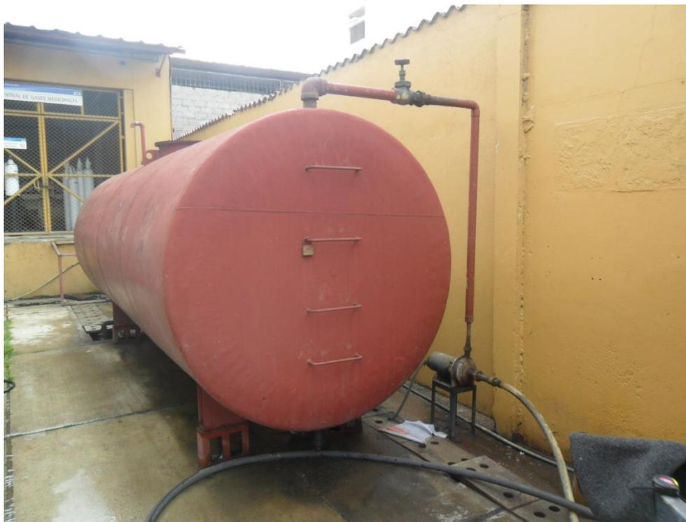
Figura 36: Tanque de almacenamiento de combustible.
