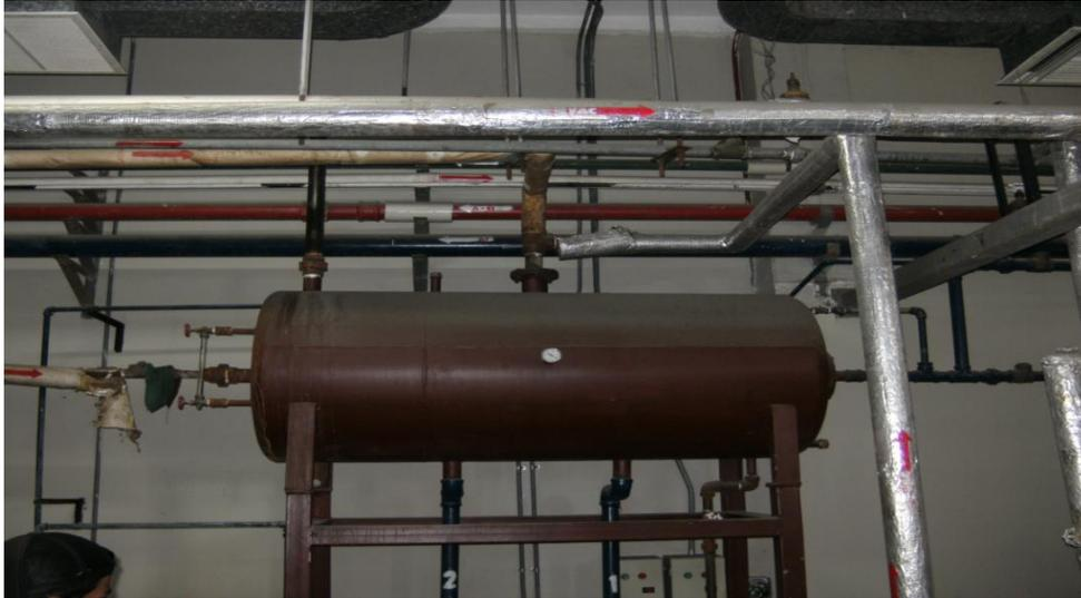
Figura 33: Circuito de ingreso del agua de alimentación 1.
