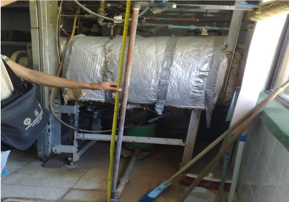
Figura 58: Tubería por donde se envía en el condensado a las cañerías en el area de esterilización.
