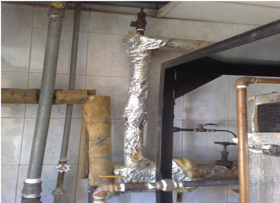
Figura 57: Aislamiento en mal estado.
