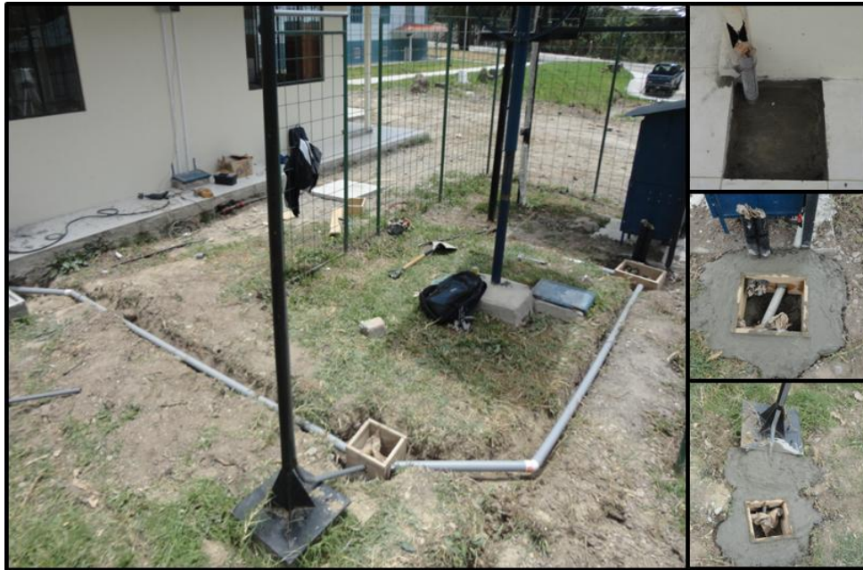
Figura 141. Colocación de la tubería en las zanjas y construcción de pozos
