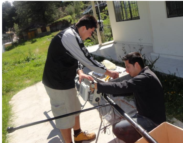
Figura 138. Conexión de los sensores de la Estación Meteorológica HOBO.
