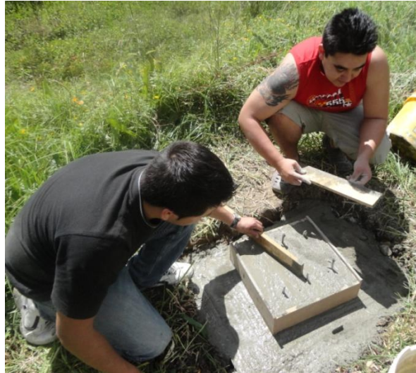
Figura 136. Construcción de la base para la estación meteorológica.
