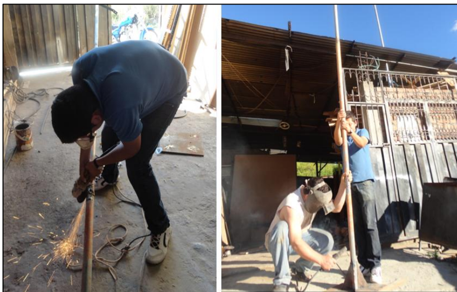
Figura 135. Remodelación de la estructura metálica de la estación
