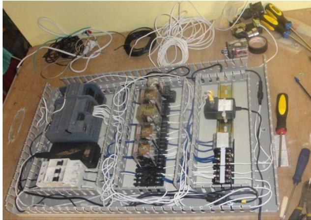
**Figura 22.** Elaboración del tablero de control (2)
