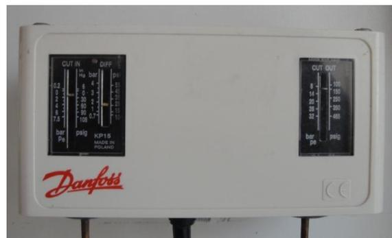
**Figura 13.** Presostato del banco de refrigeración
