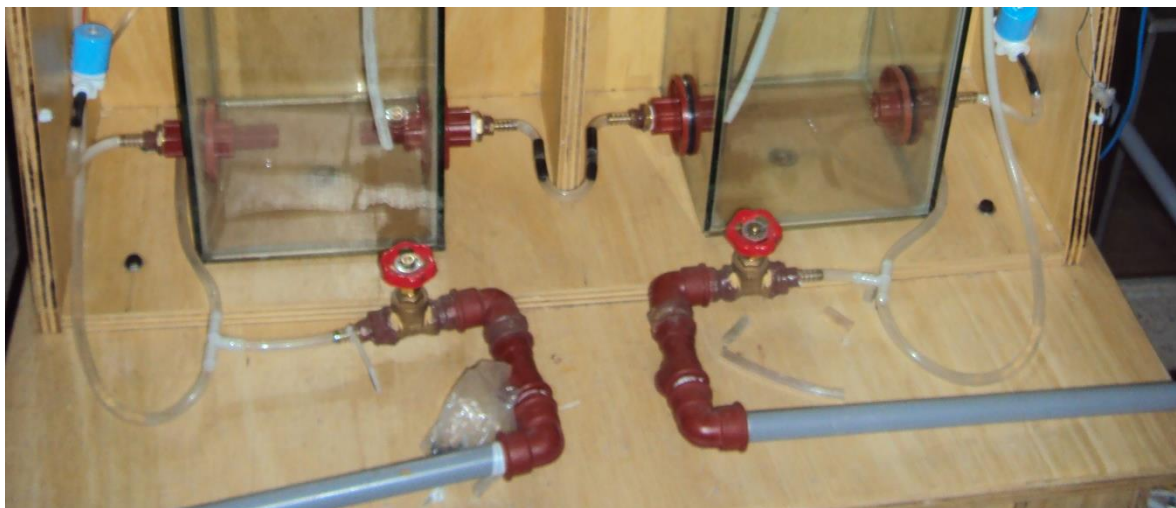
Figura 22. Bypass hacia el reservorio (Autor)
