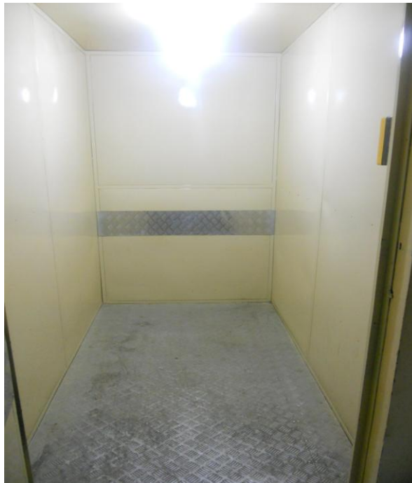
Figura 17. Cabina del montacargas
