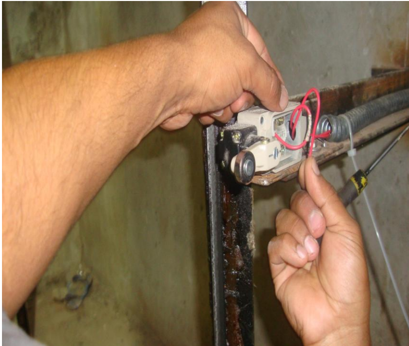
Instalación de los finales de carrera
