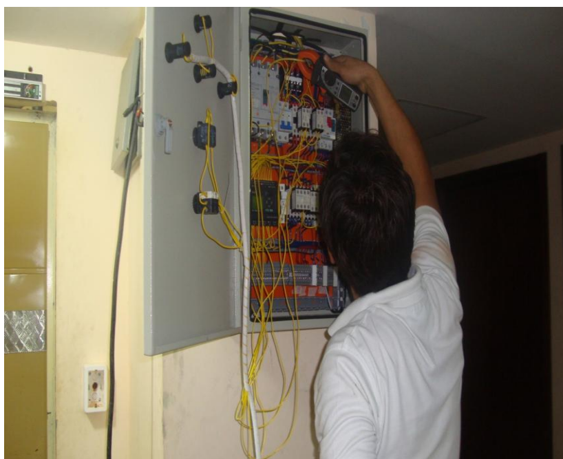
Medición de consumo de corriente de la maquina tractora
