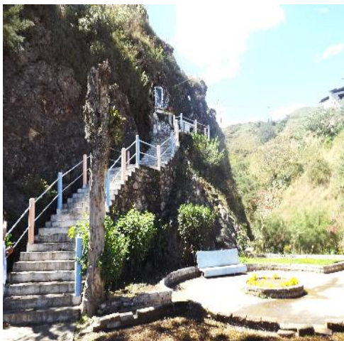
Figura 37. Escaleras Virgen Inmaculada Fuente: Trabajo de Campo Elaboración: Fernando Bravo
