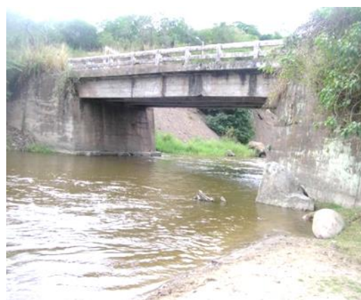
Figura 18. Puente ríos de Bella María Fuente: Trabajo de Campo Elaboración: Fernando Bravo
