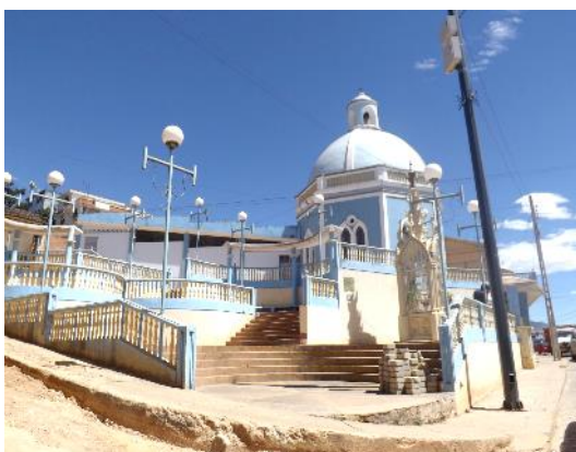
Figura 59. Capilla El Cimborio Fuente: Trabajo de Campo Elaboración: Fernando Bravo
