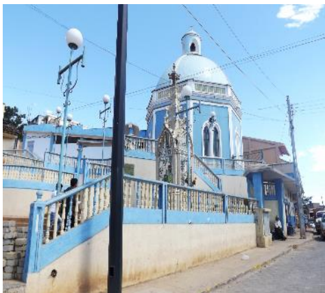
Figura 57. Capilla El Cimborio Fuente: Trabajo de Campo Elaboración: Fernando Bravo
