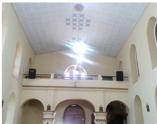
Figura 50. Sala de Coro Capilla Fuente: Trabajo de Campo Elaboración: Fernando Bravo
