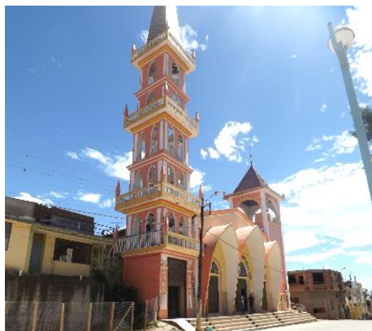
Figura 53. Fachada Santuario La Nube Fuente: Trabajo de Campo Elaboración: Fernando Bravo
