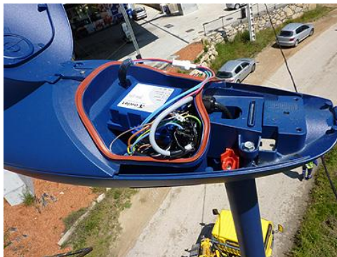
Figura 28.- Instalación de un módulo de control del Punto de Luz
