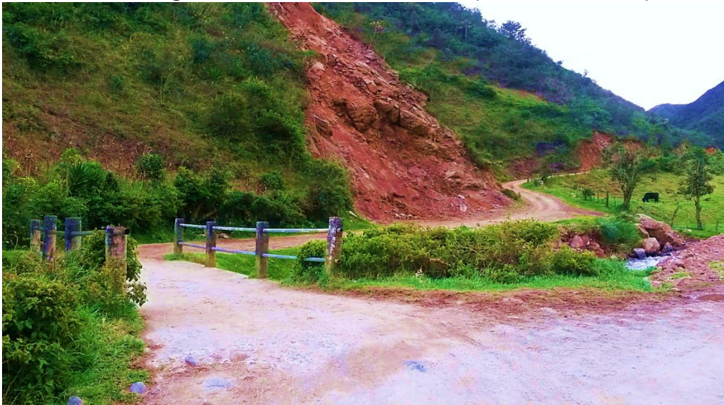
Fotografía N° 22 Puente barrio Sauce (Vía al barrio Posín)
