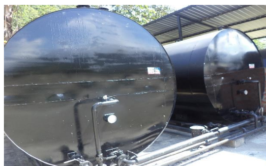
Figura 28: Tanques de Asfalto
