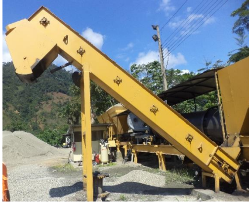
Figura 34: Elevador y silo de descarga
