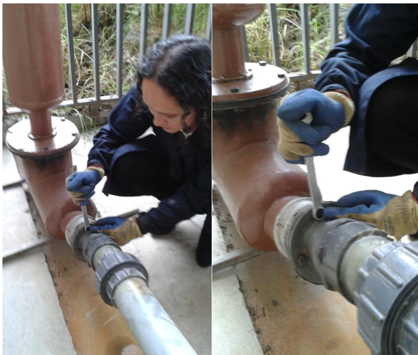
Fotografías 7 y 8 : Unión del tubo de alimentación con el acople de ampliación
