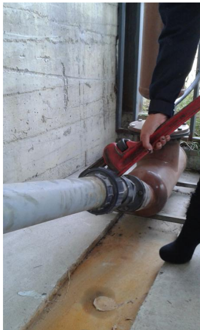
Fotografía 5 : Tubo de alimentación, Ajuste con el ariete multipulsor con válvulas en disposición circular.
