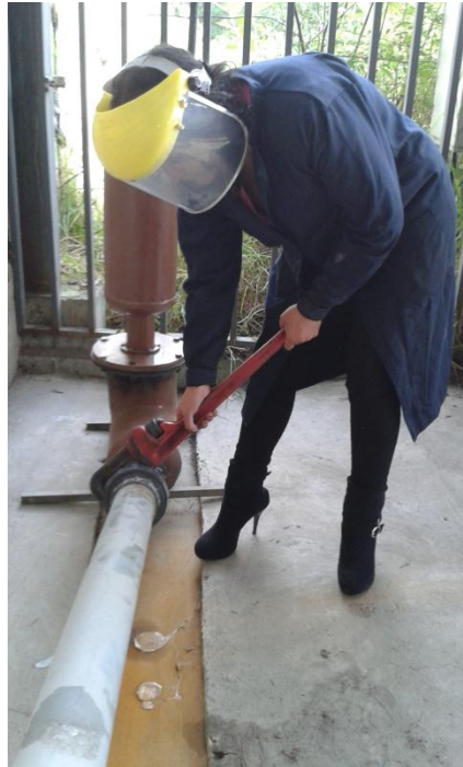
Fotografía 6 : Unión tubo de alimentación con el Ariete
