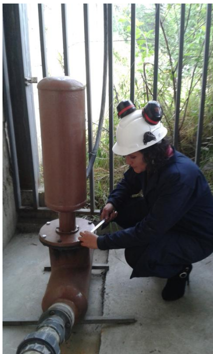
Fotografía 9 : Apriete pernos de brida superior, unión entre cámara superior y cámara inferior
