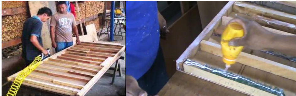
Fig. 1: Proceso constructivo de la puerta (VALENCIA, 2009).
