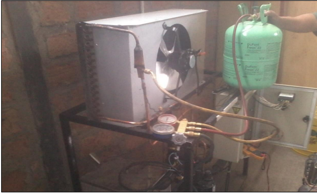
Foto 09: Cargando el refrigerante R22 al sistema de refrigeración.
