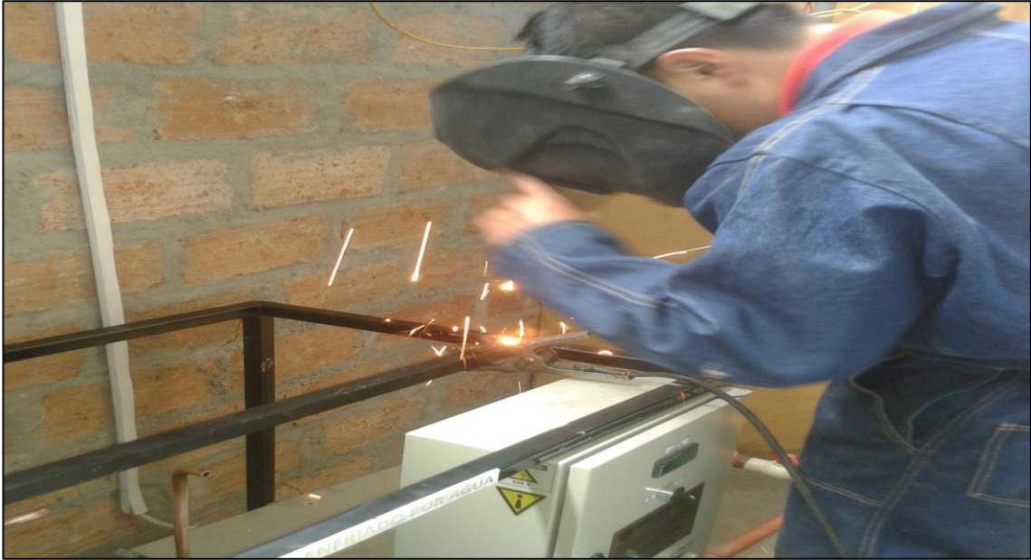
Foto 05: Soldando soporte con la suelda eléctrica en la estructura del banco.
