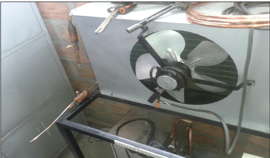
Foto 06: Asegurando el condensador a la estructura del banco.
