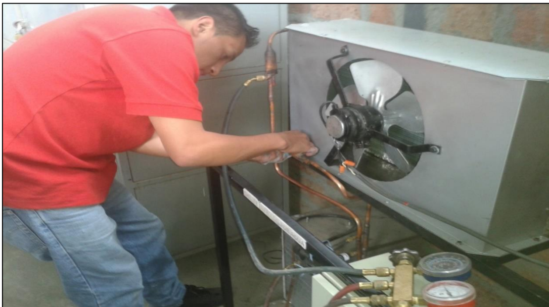
Foto 10: Comprobando si hay fugas en el sistema con agua espumosa.
