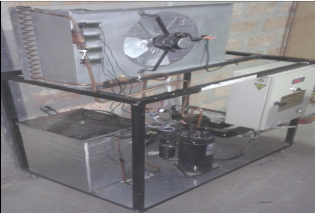
Foto 12: Banco de refrigeración de agua helada
