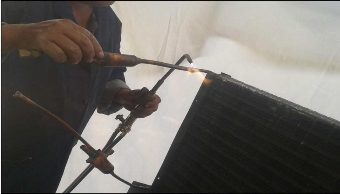
Foto 07: Soldando la tubería de cobre con la suelda oxiacetilénico.
