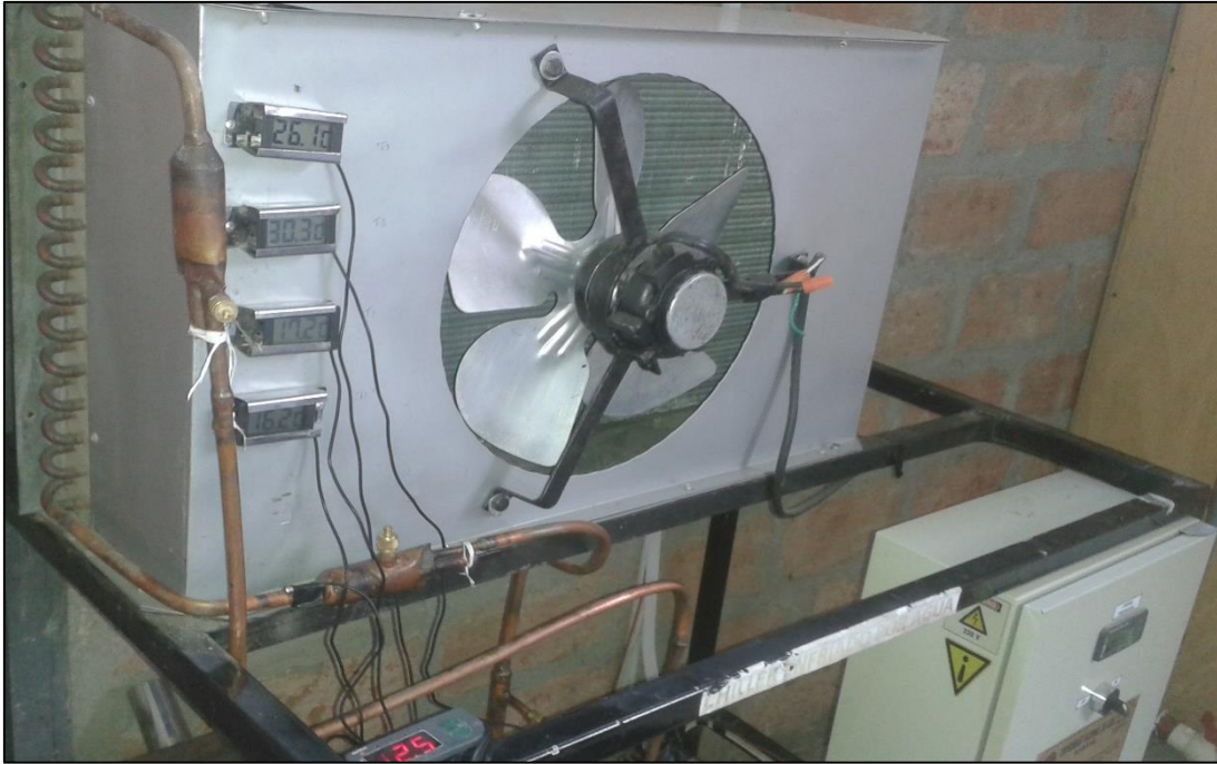
Foto 11: Instalación de los sensores de temperatura
