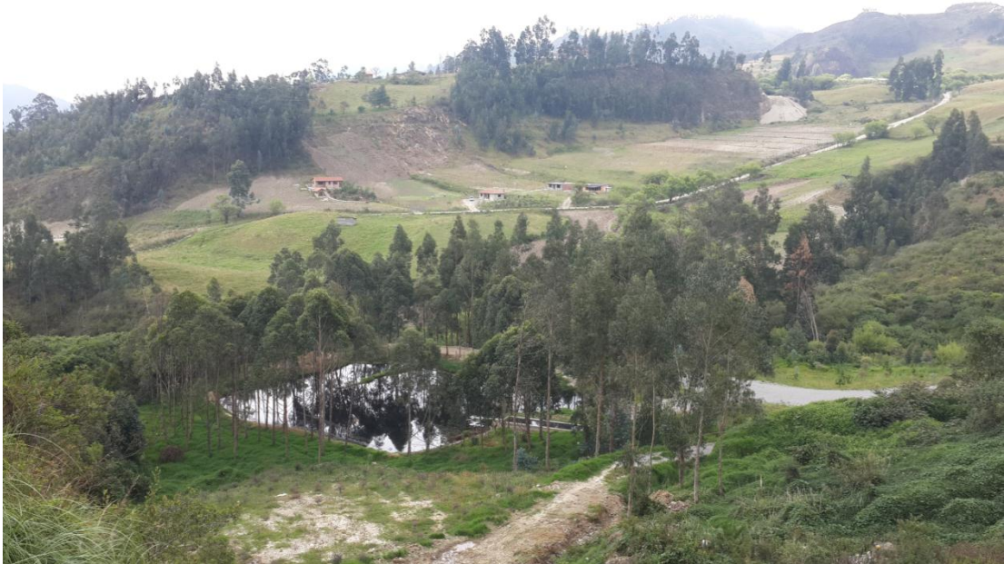
Figura 27 Laguna estabilización relleno sanitario Loja
