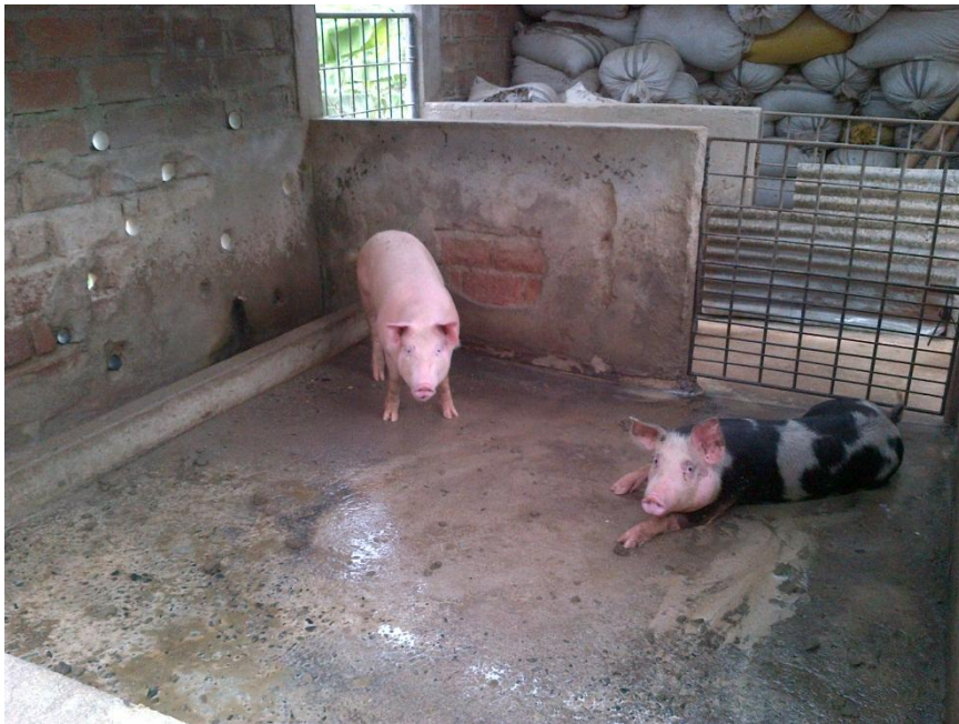
Figura 2.14. Instalación con piso de cemento y limpieza continúa
