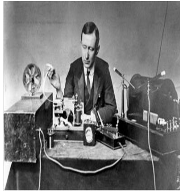
Figura 1. Sistema comunicación de Guillermo Marconi en el año de 1901
