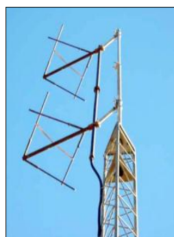
Figura 71. Sistema Radiante para IBOC FM
