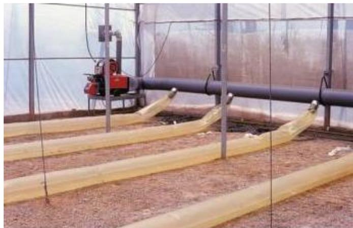
**Figura 8.** Generadores de aire caliente de combustión indirecta y mangas de distribución de plástico flexible. [6]
