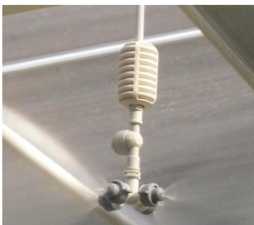
**Figura 41.** Nebulizador Coolnet de 4 boquillas.
