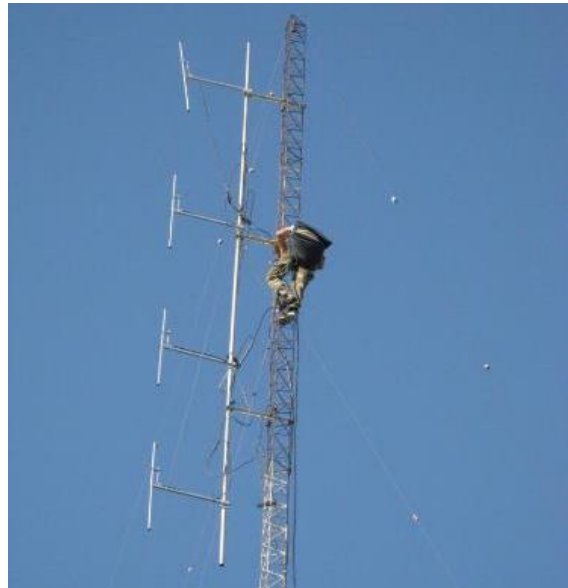
Figura 45. Arreglo de 4 antenas omnidireccionales.
