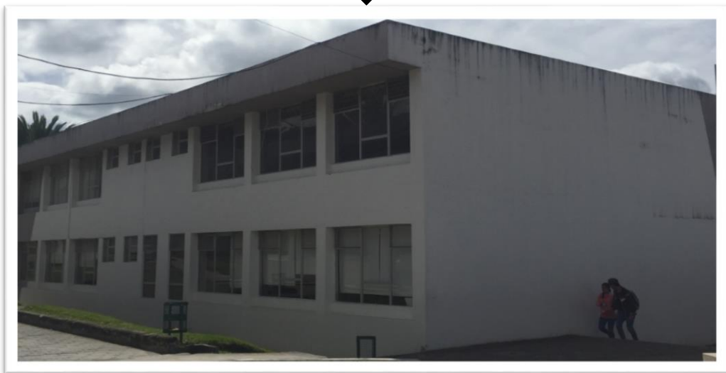
Vista posterior del edificio de la carrera de Informatica Educativa.
