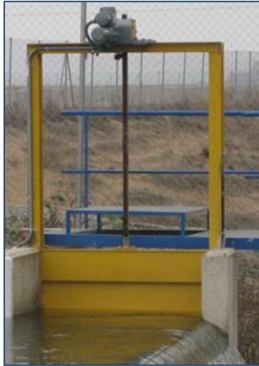
**Figura 7. Compuerta del Canal de Pinyana (Lleida, España) [8].**
