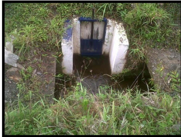
Figura 11. Caja de riego ubicada en el canal.
