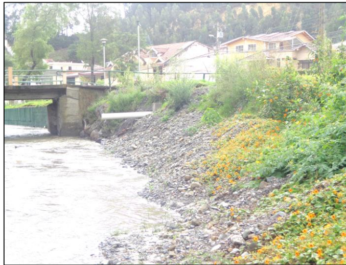
Figura 11. Descarga de aguas pluviales en el río Zamora Huayco
