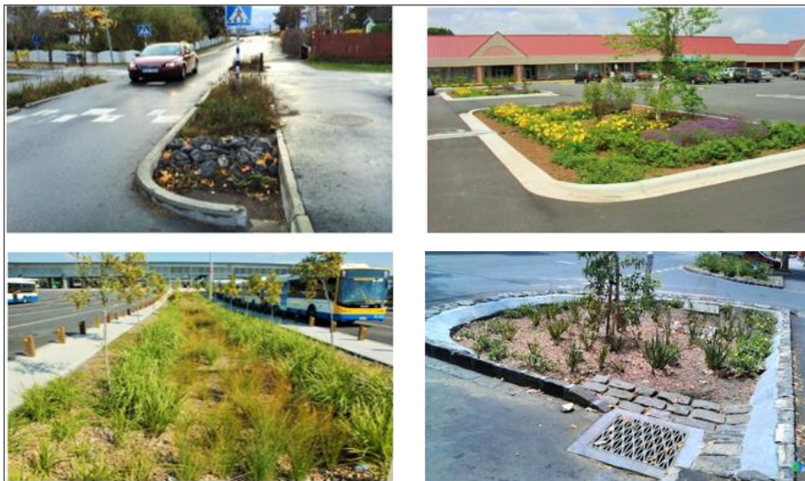
Figura 16. Ejemplos de celdas de biorretención Fuente: Blecken et al. (2015)
