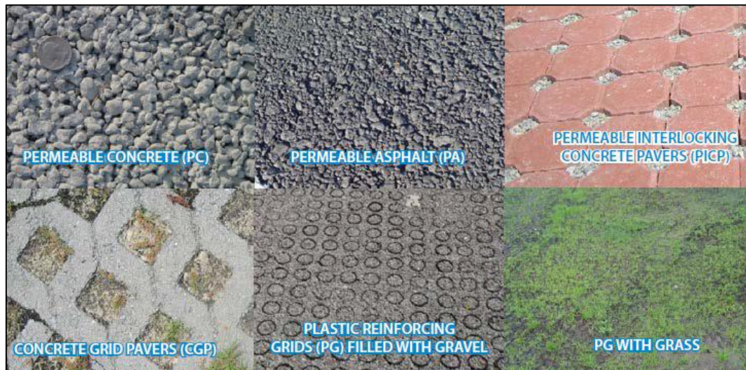
Figura 14. Tipos de pavimento permeable Fuente: Hunt and Collins (2008)
