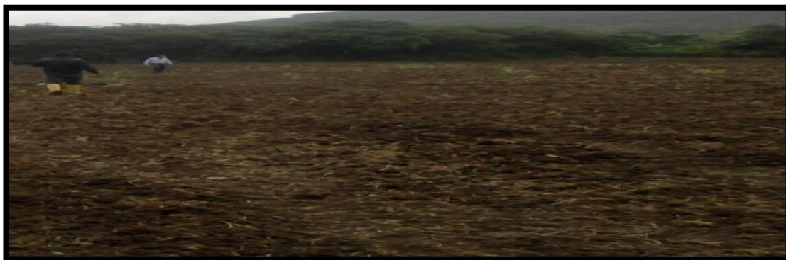
Foto1. Preparación del Terreno, realizado el 12-06-2013.
