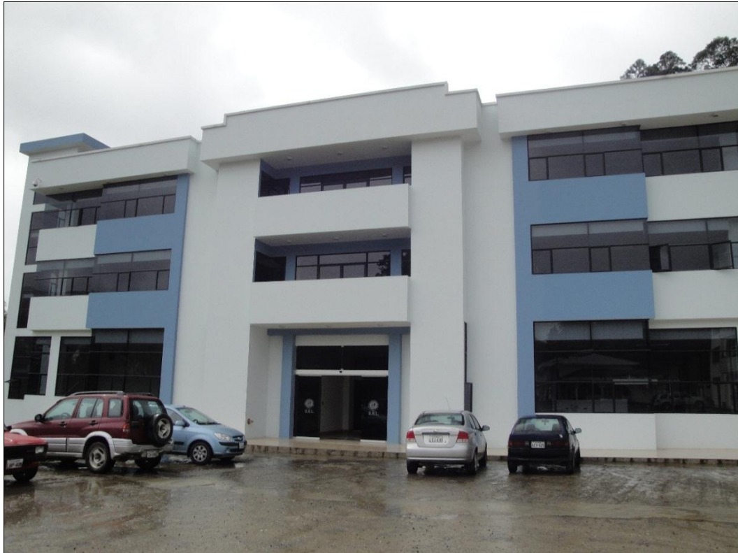
Fig. 2 Edificio de Laboratorios Técnicos. (Autora)
