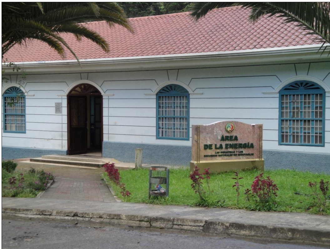
Fig. 1 Edificio Administrativo del Área de la Energía, las Industrias y los Recursos Naturales No Renovables. (Autora)
