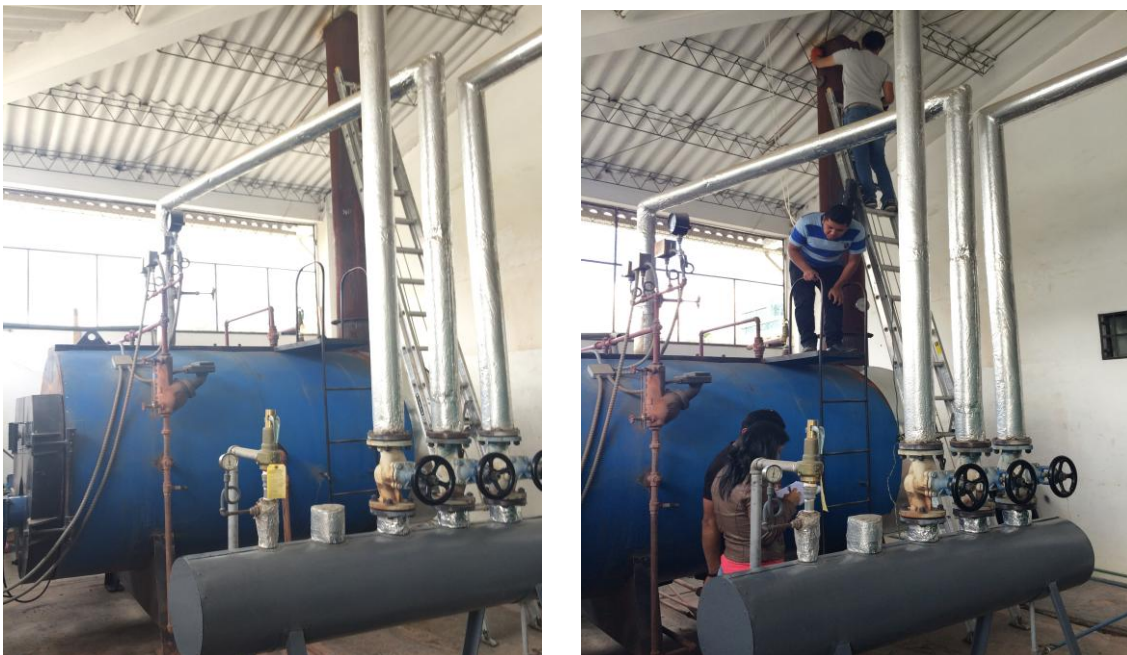
Figura 30. Medición y registro de gases contaminantes en la empresa CAFRILOSA caldera 1.
