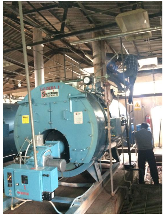
Figura 33. Medición y registro de gases contaminantes del Hospital del IEES.
