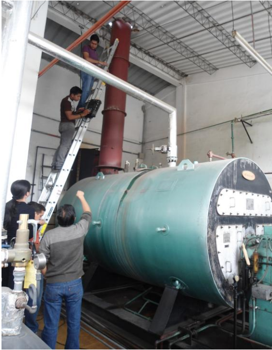
Figura 31. Medición y registro de gases contaminantes en la empresa CAFRILOSA caldera 2.
