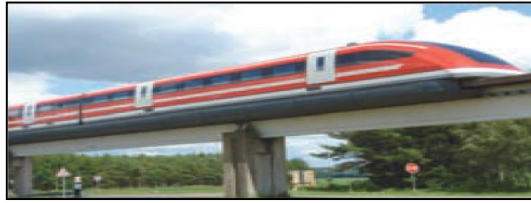
Figura 22. Tren de Levitación Magnética, tomado del libro Máquinas Eléctricas de Juan Carlos Martín
