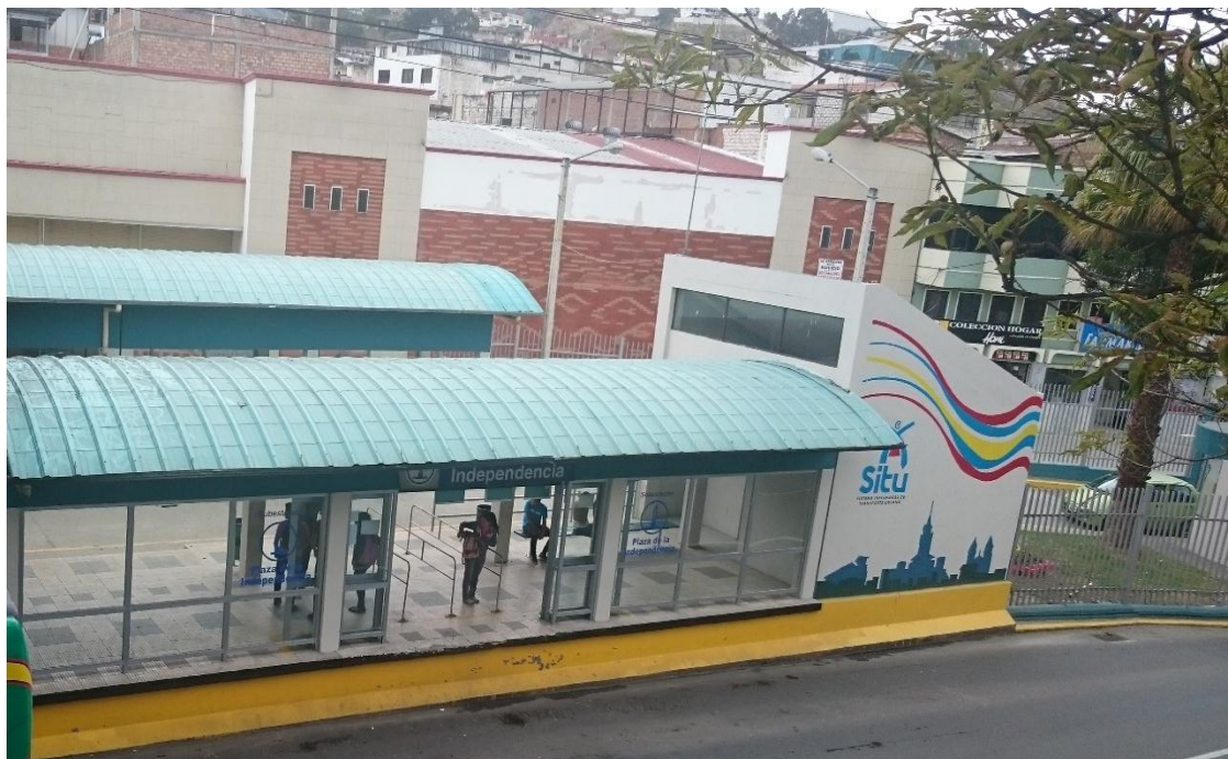
Figura 10.- Sub-Estación de Transferencia “Plaza de la Independencia”
