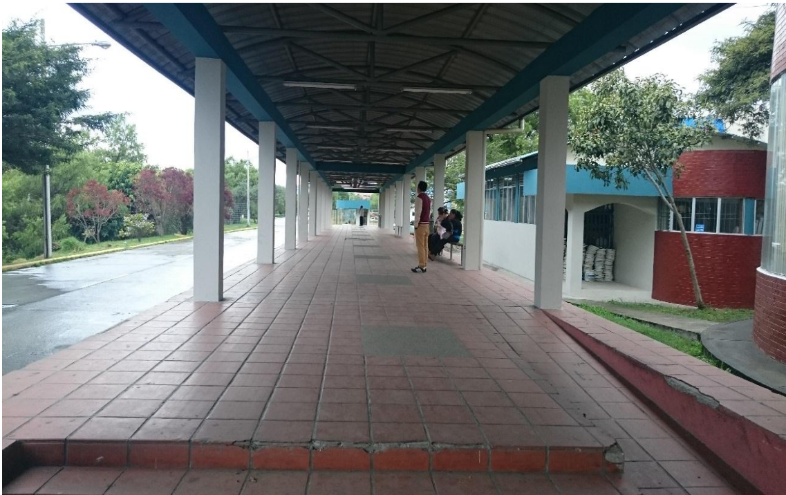
Figura 11.- Sub-Estación de Transferencia “Podocarpus”
