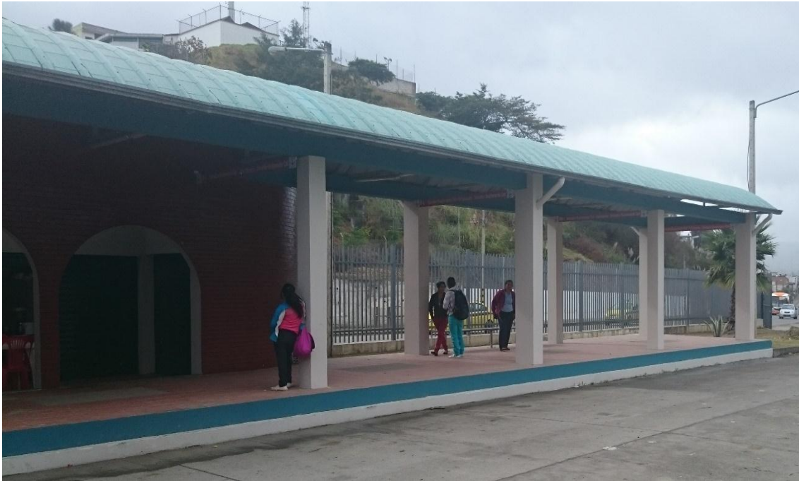
Figura 13.- Sub-Estación de Transferencia “Pablo Palacio”
