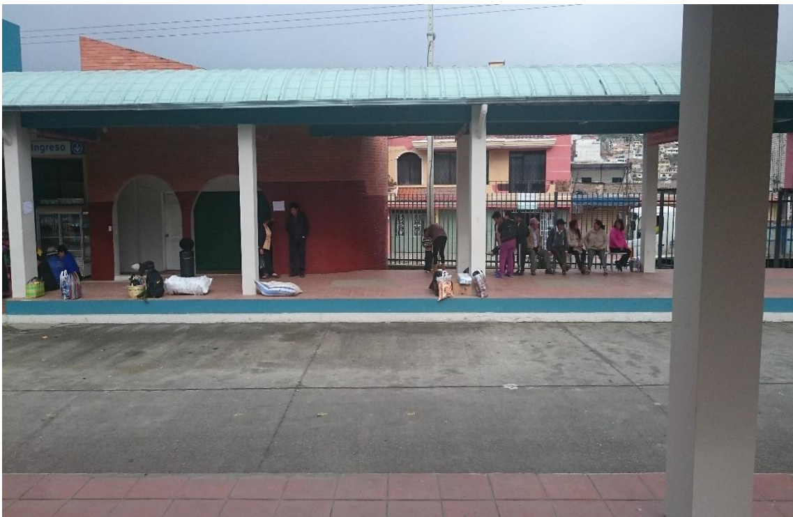
Figura 12.- Sub-Estación de Transferencia “Salvador Bustamante Celi”
