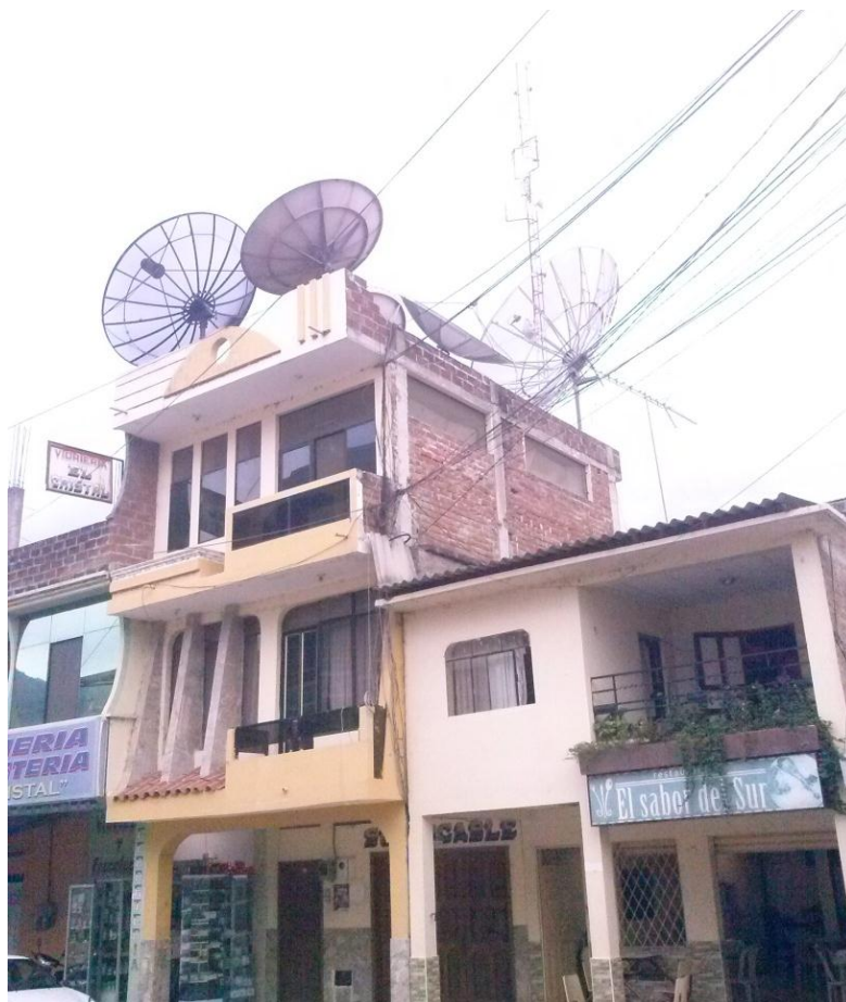
Figura. 17. Estación Terrena "SUPERCABLEFILS"
