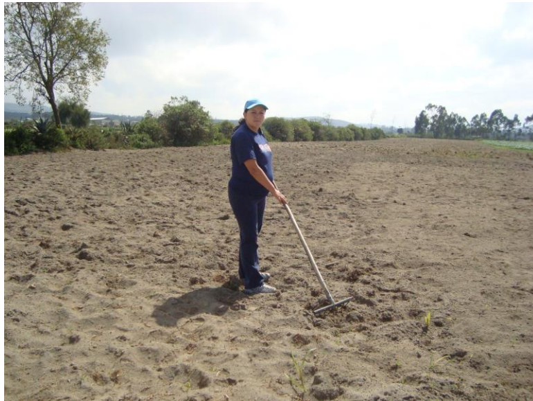
FOTO 6 LIMPIEZA-NIVELADO DEL SUELO
