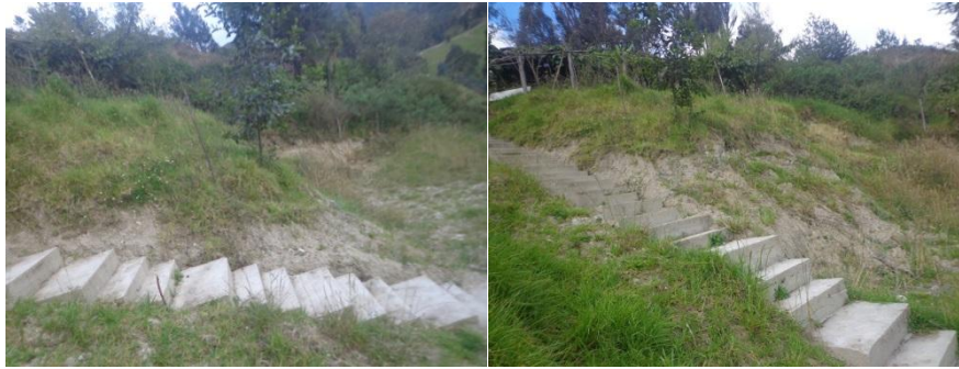
Gráfico 29. Muro de contención con neumáticos usados en la Quinta Agroturística – ecológica, en Yanacocha en la ciudad de Loja. Septiembre 2014.
