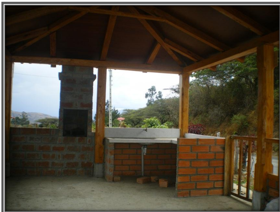
Interior de la caseta
