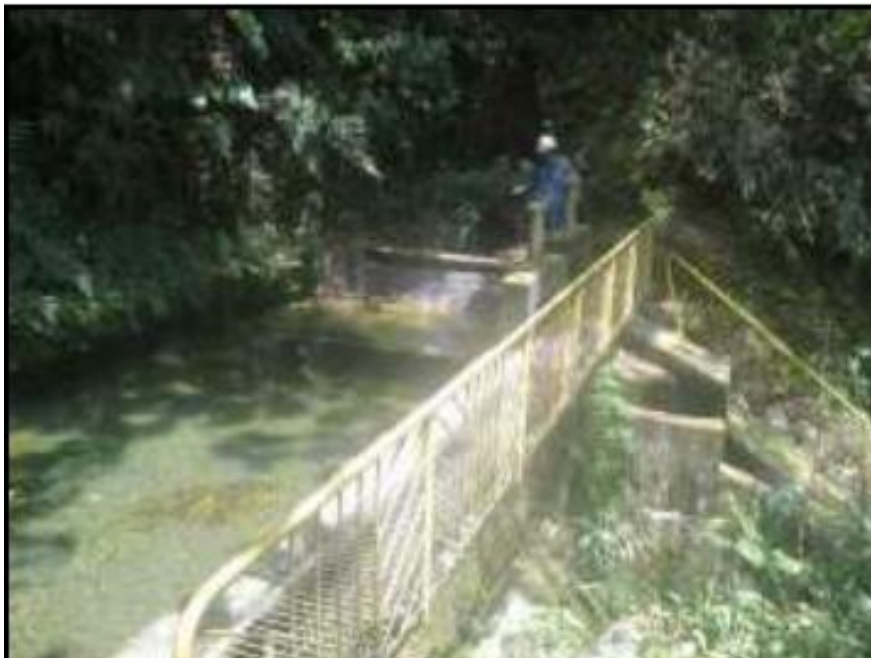
Figura 5.4. Captación río San Ramón
