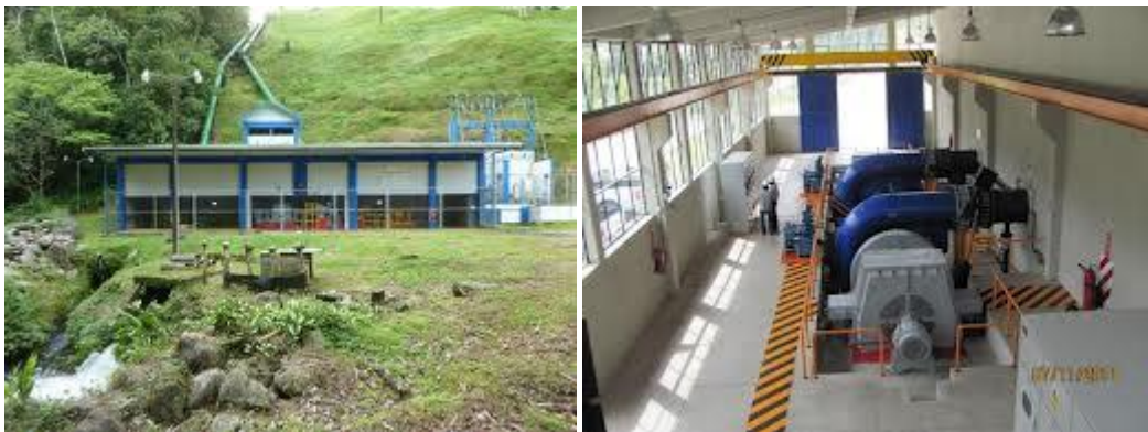
Figura 2.18. Interior y Exterior de una casa de máquinas.
