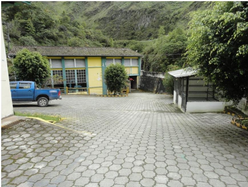
Figura 5.14. Casa de Máquinas
