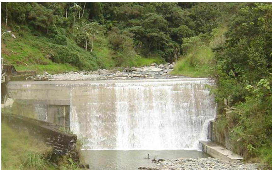
Figura 5.2. Azud sobre el río San Francisco
