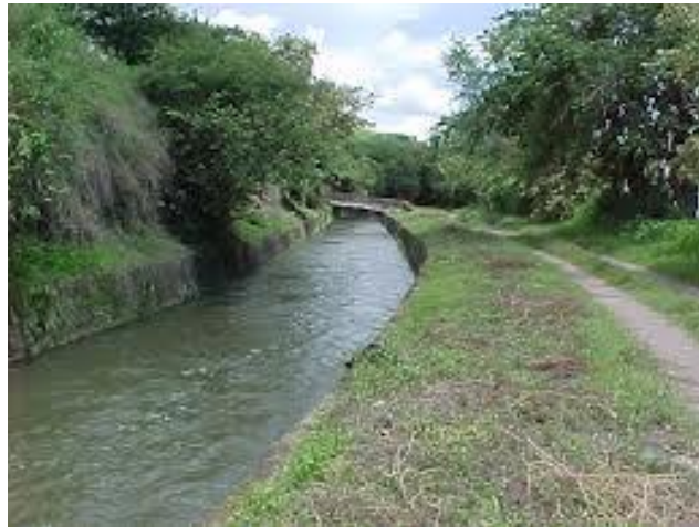
Figura 2.12. Canal de conducción de agua
