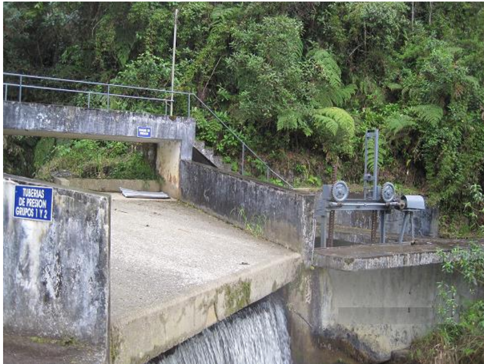
Figura 5.12. Tanques de tubería de presión de Grupos 1 y 2
