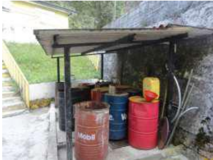
Figura 5.26. Zona de depósito temporal de aceites usados con cubetos de hormigón
