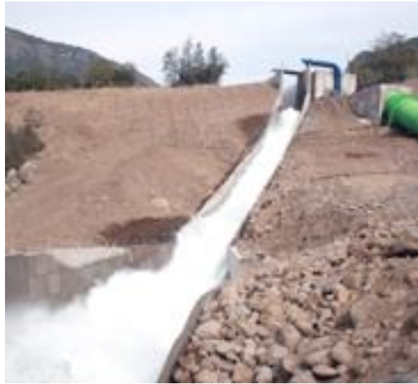
Figura 2.10. Aliviadero de una Central Hidroeléctrica de Pasada
