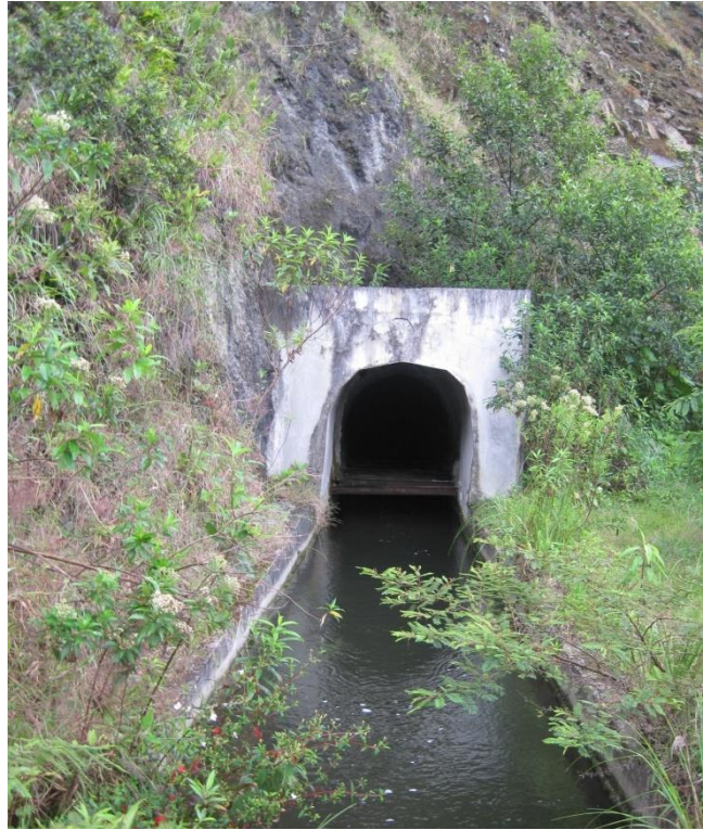
Figura 5.8. Salida túnel San Francisco
