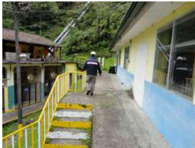
Figura 5.30. Barandas de seguridad central hidroeléctrica
