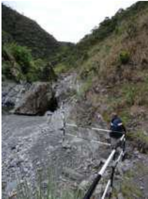
Figura 5.29. Barandas de seguridad acceso a la captación
