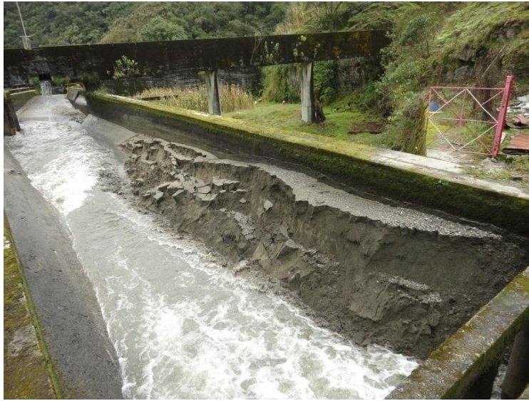
Figura 5.9. Desarenador canal de conducción San Francisco
