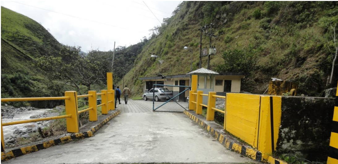
Figura 5.21. Casa de Guardián S/E Central Hidroeléctrica Carlos Mora
