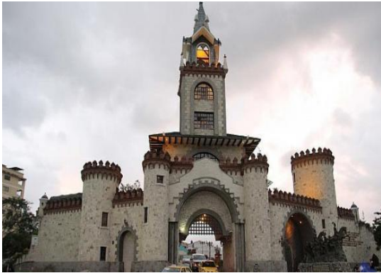
FIGURA N° 41: Puerta de la Ciudad
