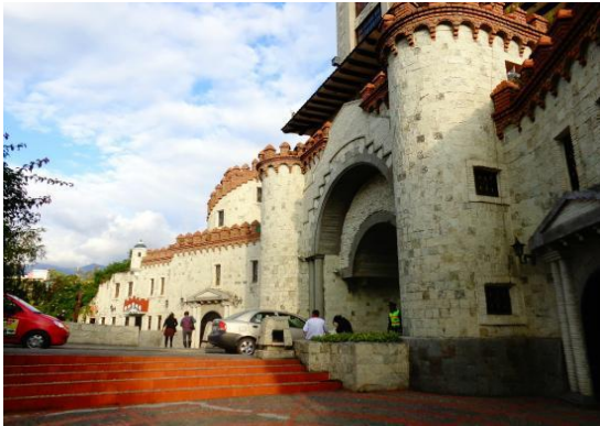
FIGURA N°43: Puerta de la Ciudad
