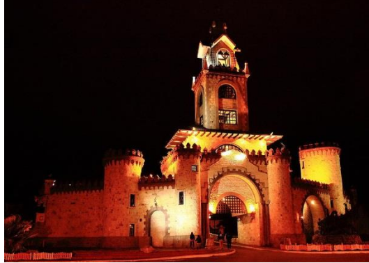
FIGURA N° 42: Puerta de la Ciudad
