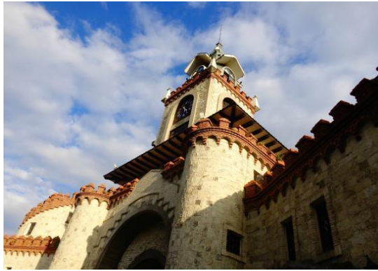
FIGURA N° 44: Puerta de la Ciudad
