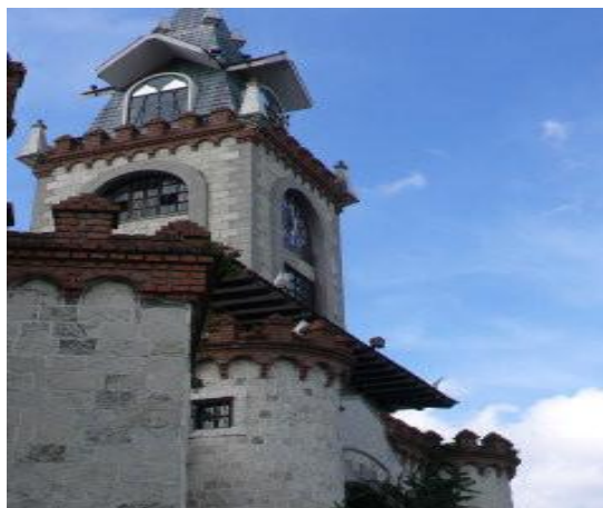
FIGURA N°45: Puerta de la Ciudad
