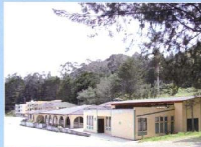
Ambientes del Área de Energía
