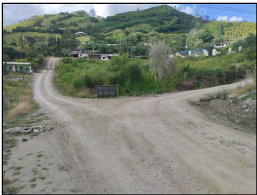
Figura 65: Vías d acceso
