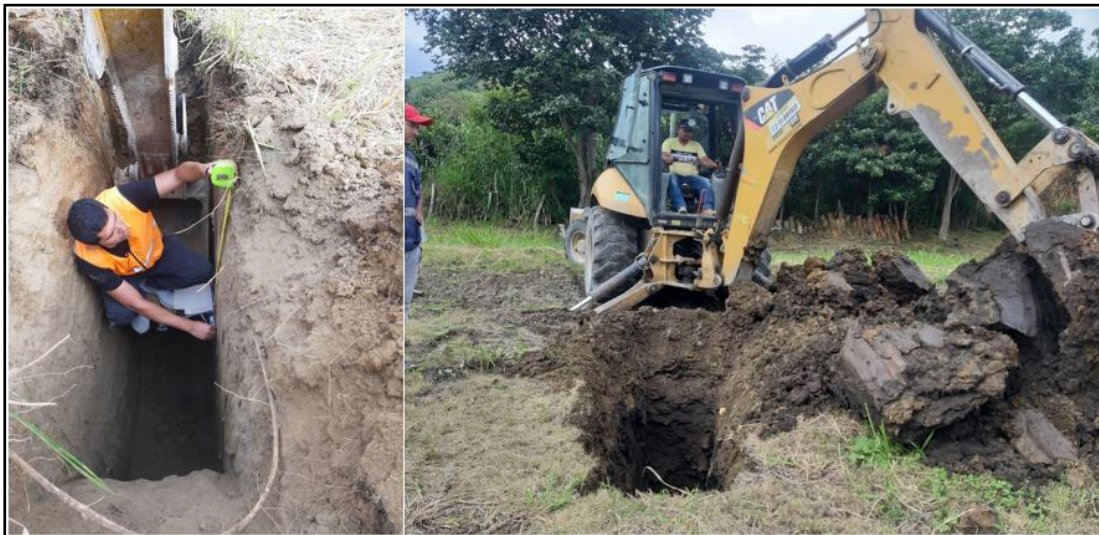
Figura 34: Realización de calicatas geológicas
