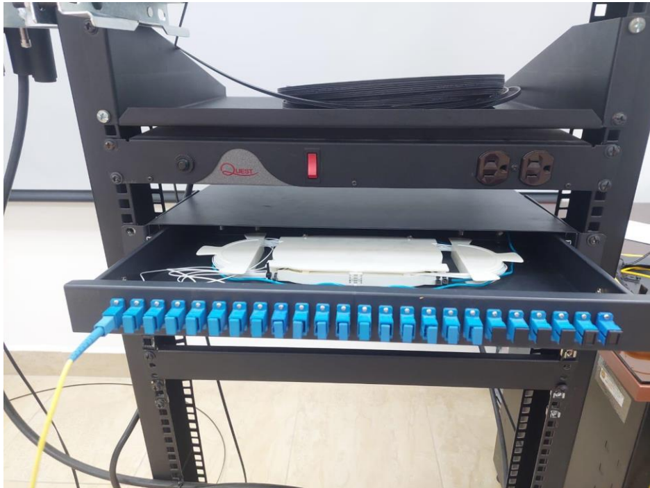
Figura 12 Conexión al ODF rackeable
