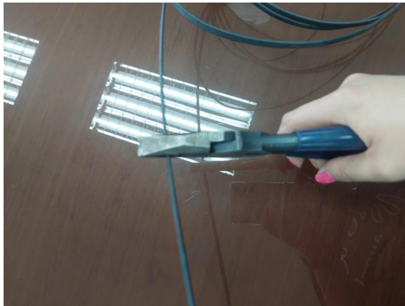
Figura 82 Cortar con el alicate la longitud deseada
