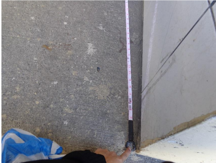
Mediciones de la longitud del tunel.
