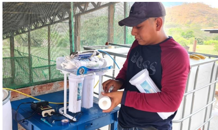
Figura 48. Montaje del equipo para el sistema potabilizador
