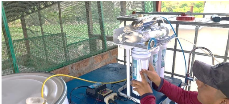
Figura 50. Instalaciones de filtros el sistema potabilizador, colocación de contenedores. Fuente: Autor
