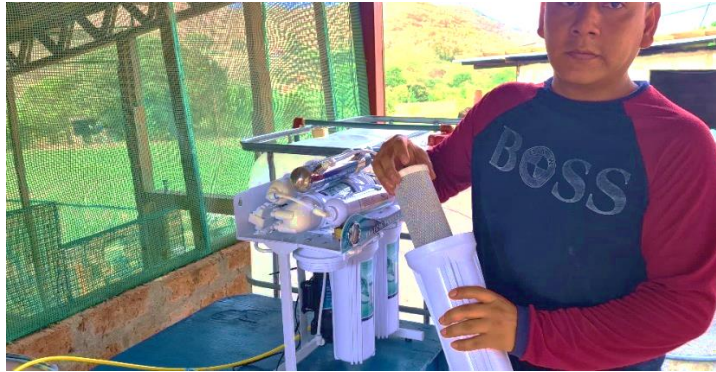
Figura 49. Instalación de filtros para el sistema potabilizador Fuente: Autor
