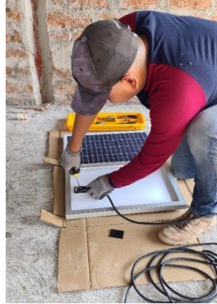
Figura 43. Instalación de conductor en los paneles solares. Fuente: Autor
