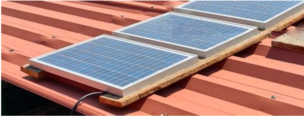
Figura 45. Paneles completamente instalados. Fuente: Autor
