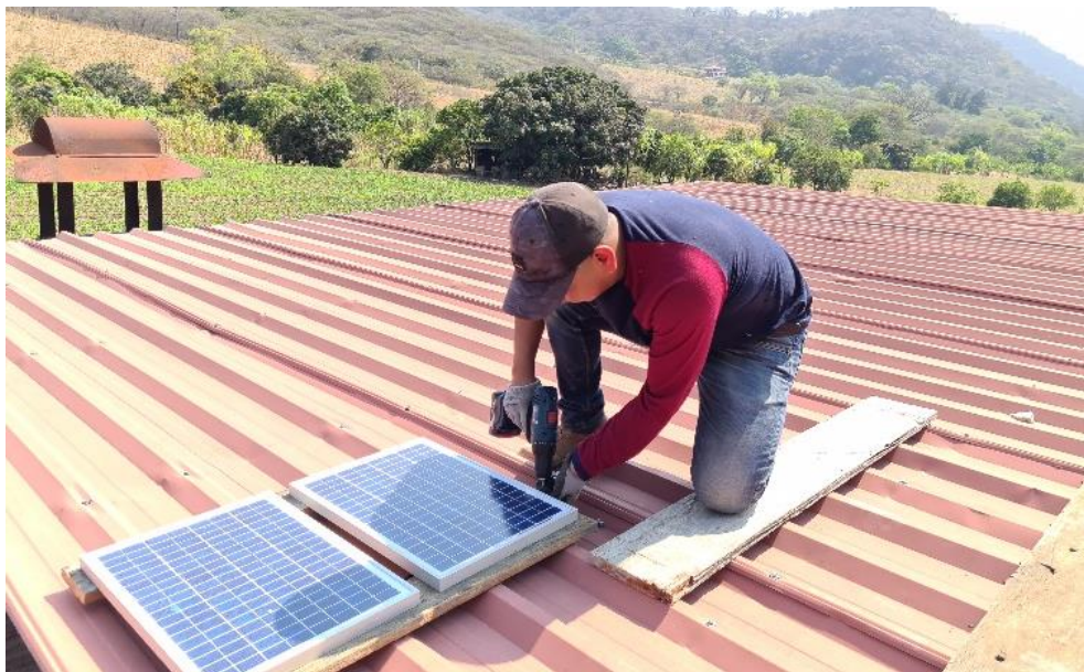
Figura 44. Montaje y aseguramiento de paneles solares en la cubierta de la vivienda Fuente: Autor
