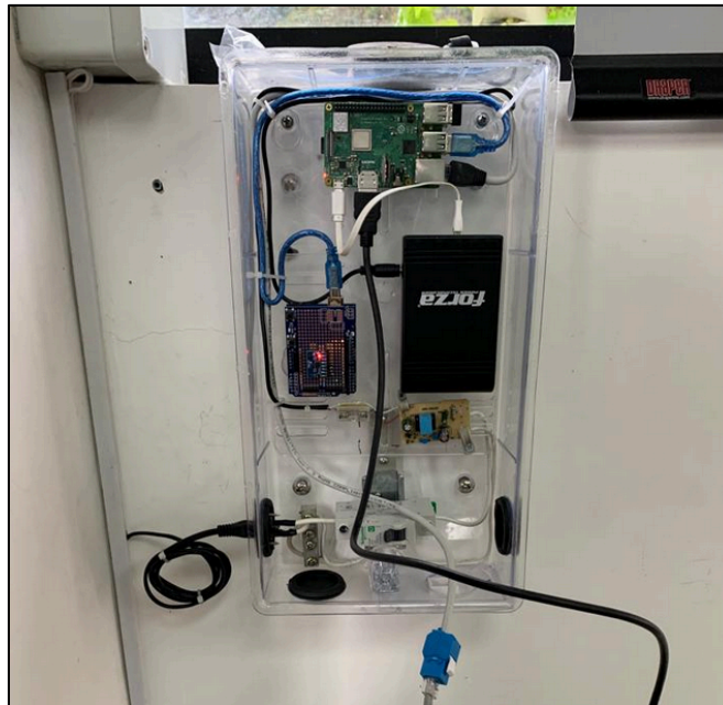
Figura 12. Estación Sísmica instalada en el I2TEC de la UNL
