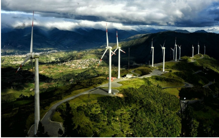
Figura 4. Central Eólica Villonaco.
