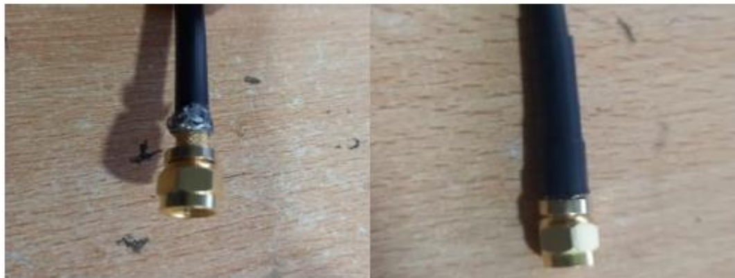
Fig. 5: Preparación y acople del conector SMA con el cable RG58.
