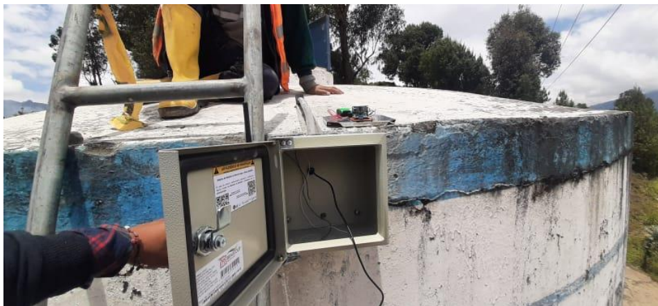
Figura 55. Instalación del Gabinete Metálico.
