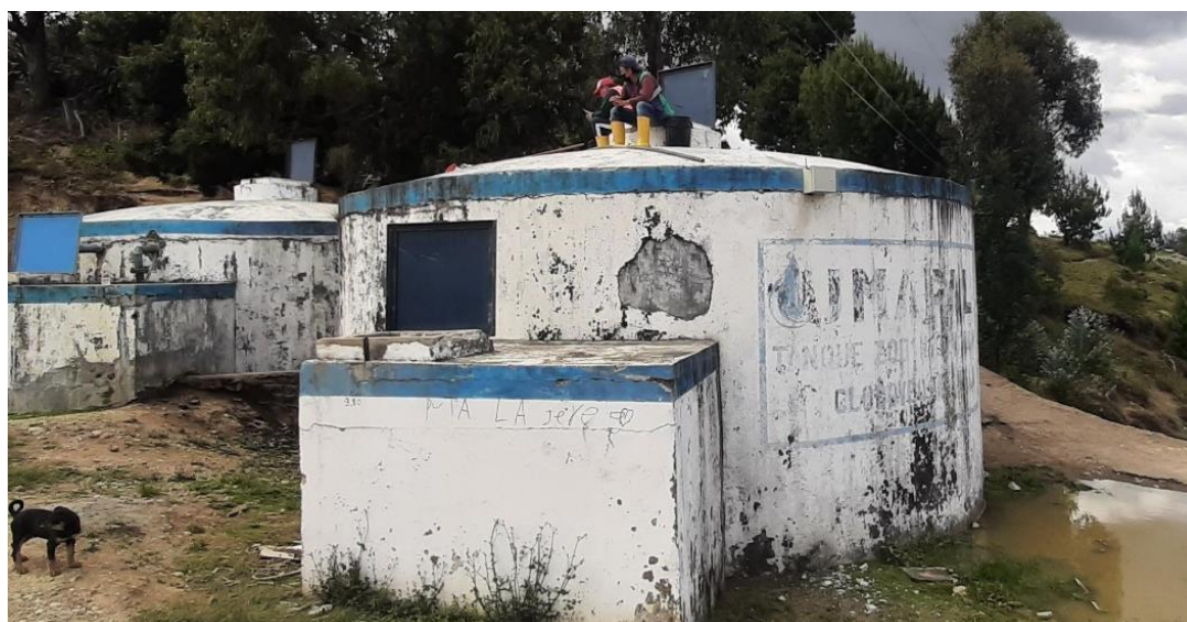
Figura 58. Vista del Tanque con el Equipo Instalado.
