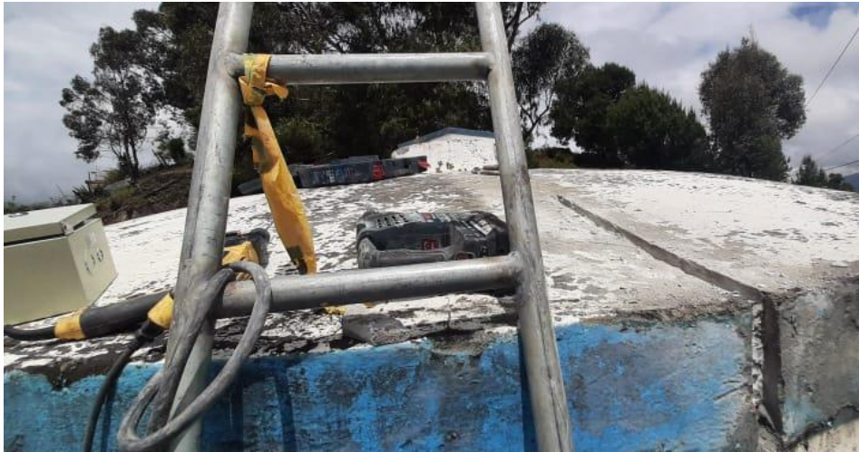
Figura 54. Zanja Para la Manguera Corrugada.
