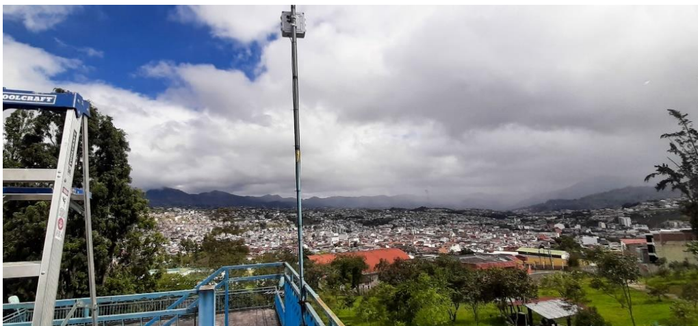
Figura 62. Línea de Vista del Gateway
