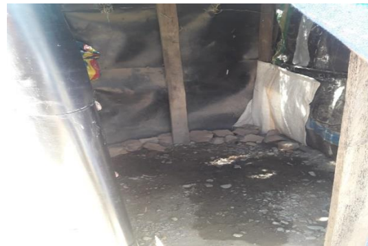
Figura 24: Lugar donde eliminan las excretas, los desechos sólidos son retirados y lanzado al campo.
