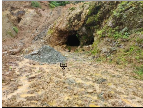
Figura 20. Señalización previa al levantamiento topografico subterráneo
