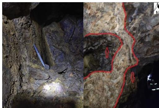
Figura 46. Falla Normal tomada a 015.16m de la bocamina
